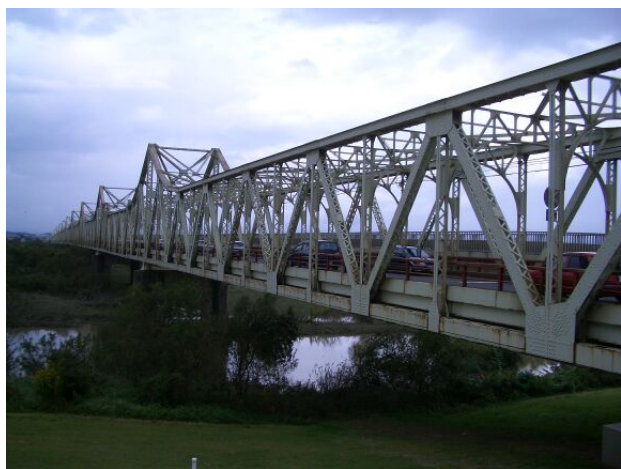
写真-1 参照橋梁の全景
