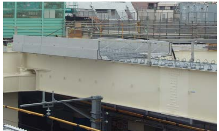
図-2 HPCa 版設置状況写真
