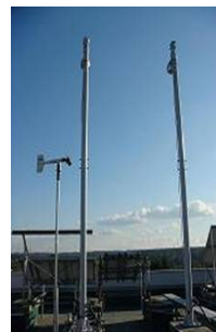
写真-2 長期計測鋼管柱 設置状況
