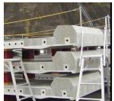
写真3. 地覆の一体製作
