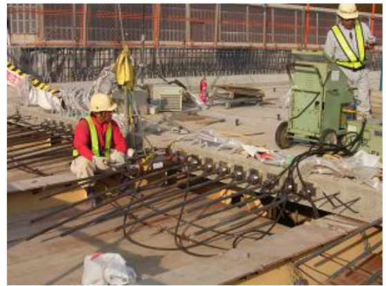
写真 2 . 橋軸方向プレストレス導入状況
