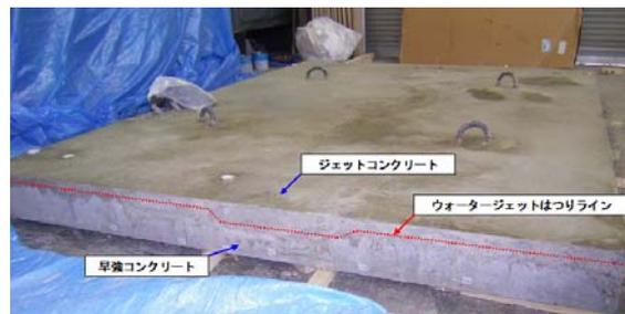
写真-1 ジェットコンクリートによる補修
