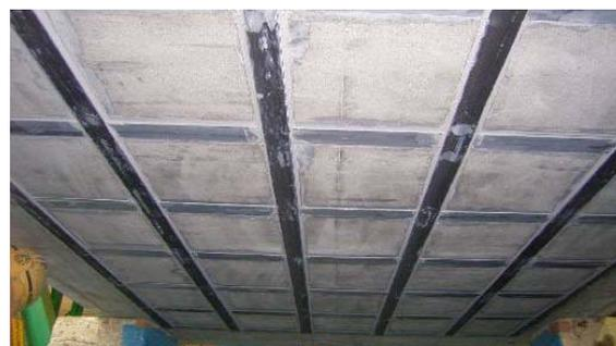
写真-2 CFRPプレートによる補強
