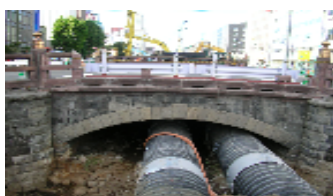
図1 創成橋の外観
