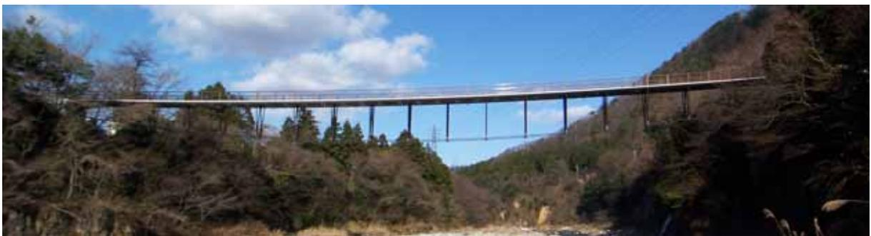
写真-1 手取渓谷に完成した外ケーブル併用PC吊床版橋
