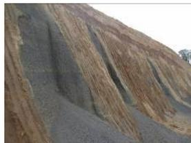
写真4 砂塊の崩壊
