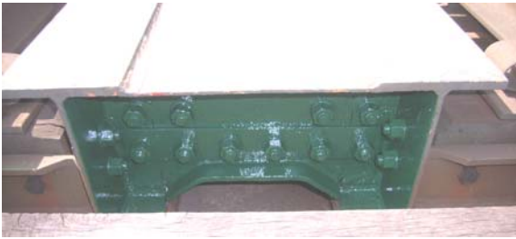
写真-6 修繕完了状況
