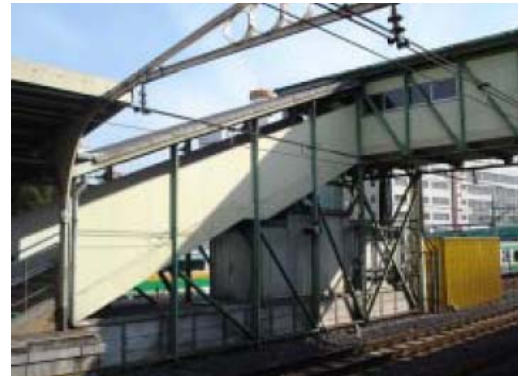
写真-1 古レール造乗換え跨線橋例
