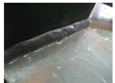
図 2 アンダーカットの外観
