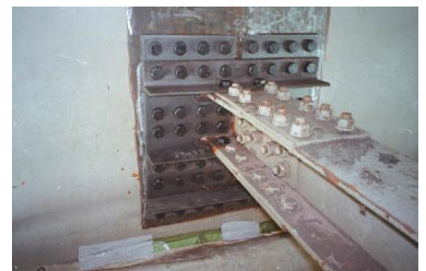
図3 アングル材を用いた補修法
