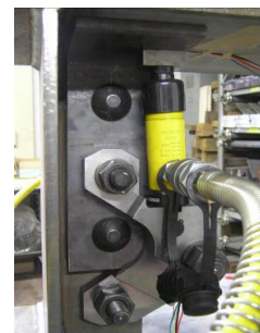
写真1 ジャッキ設置状況
