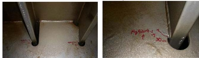
図 2 調査対象横リブと発生疲労亀裂
