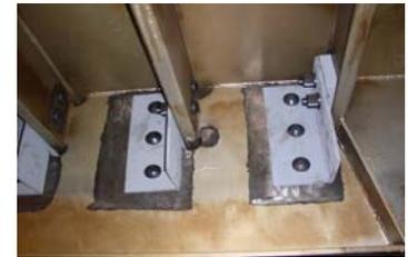
図 1 形鋼による補強
