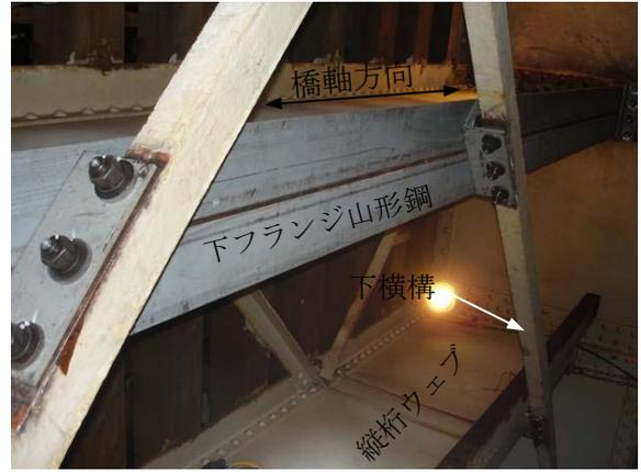
写真-3 縦桁下フランジ取替え後
