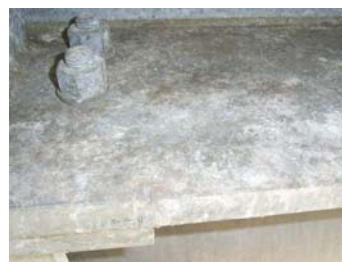
写真-5 溶融亜鉛めっきの状況
