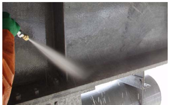
b) 高圧水による洗浄状況
