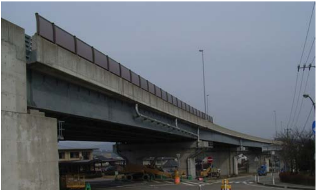
写真-1 内日角高架橋の全景
