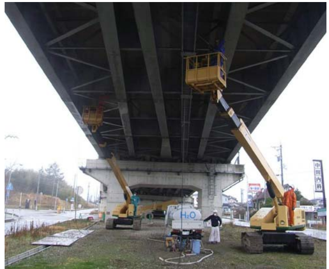
a) 使用器材と作業員の配置状況
