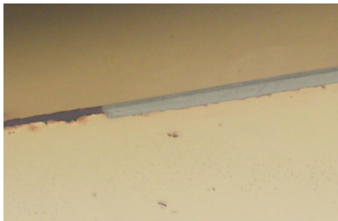
写真-1 箱桁フランジ上下面への亜鉛テープ設置
