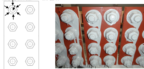
図-2 施工試験体
