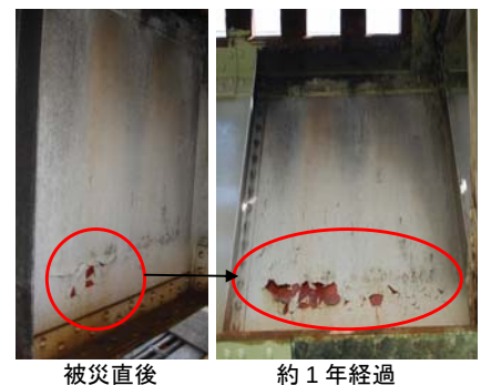
図 1 被災した橋りょうにおける早期の塗膜変状 2)
