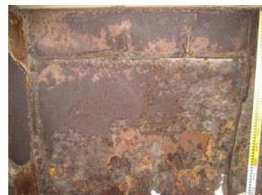
写真 4 G3 桁端部主桁海側の腐食劣化
