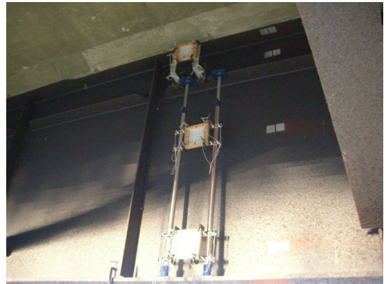
写真-2 塩分捕集器具，曝露試験片の設置状況
