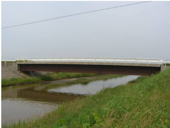
写真-1 対象橋梁の全景 (上流側より撮影)
