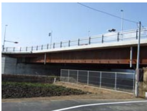
写真3 新設の耐候性鋼橋
