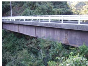
写真1 耐候性鋼橋
