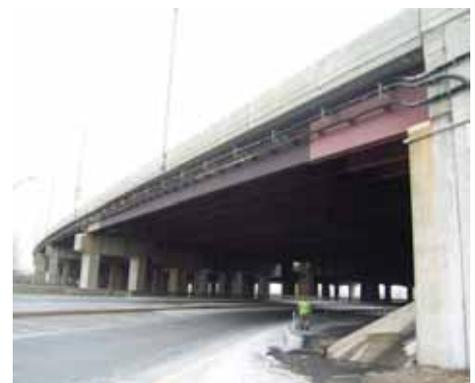
図-4 桁端塗装と漏水対策を徹底した橋梁
