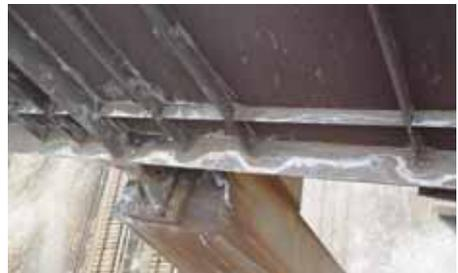
図-2 凍結防止剤が付着した橋桁(ニュージャージー)
