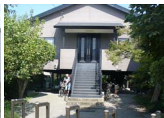
写真-2 ピロティ建築
