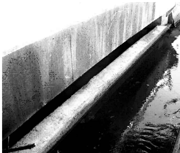
写真一1 鴨川の乗越堤の現状
