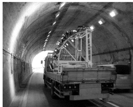
図-2 トンネル覆工のビデオ撮影
