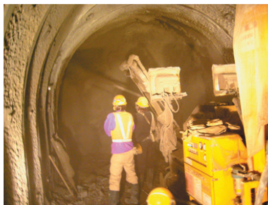
図2 吹付け施工状況
