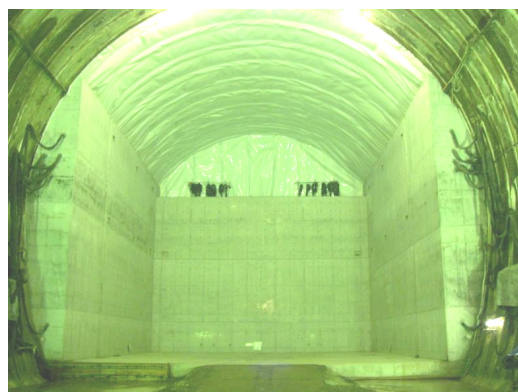
写真-2 底部・側部埋戻し材完成写真
