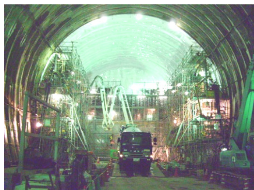
写真-1 底部・側部埋戻し材施工状況
