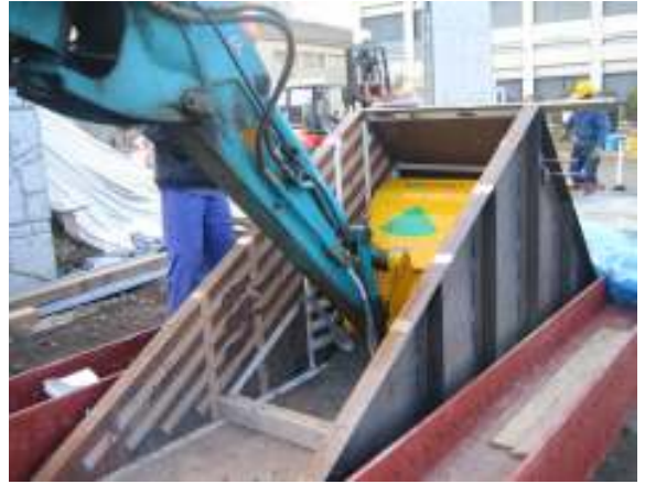
写真-2 斜め締固め実験用型枠および実験状況
