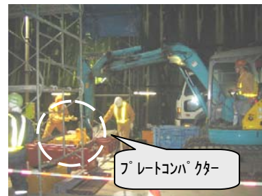
図-1 プレートコンパクターによる締固め
