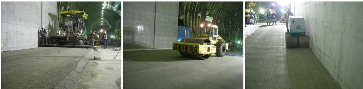
写真-1 材料撒き出し状況
