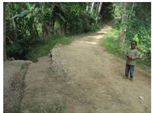
写真3 写真1に示す箇所を「土のう」で整備後、約2年経過時の様子 (2008年3月, パプアニューギニア)
