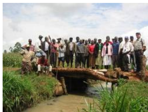
写真5 橋の補修を行った村人ら(ケニア)
