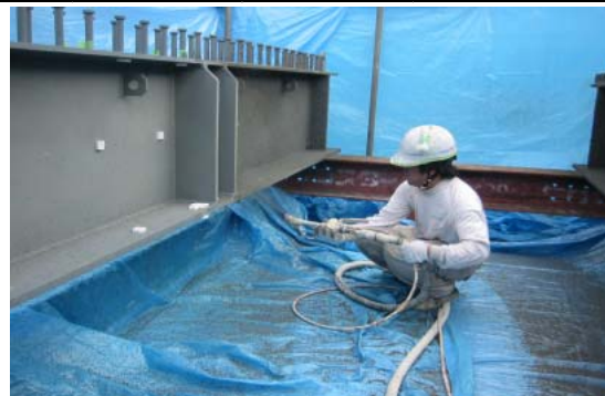
図 3.1 吹き付け施工の様子
