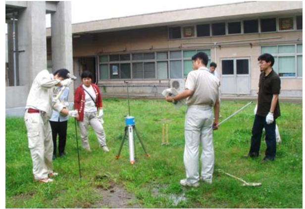
写真4 鉄筋を用いた簡易判定法などの現場試験
