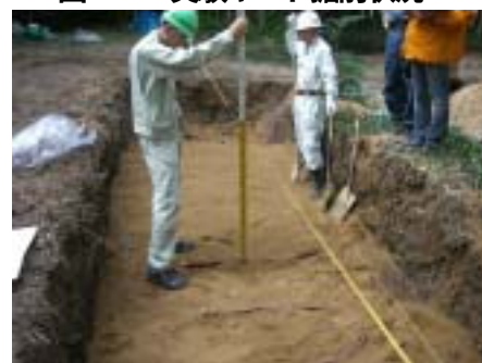
図-3 実験ヤード製作状況
