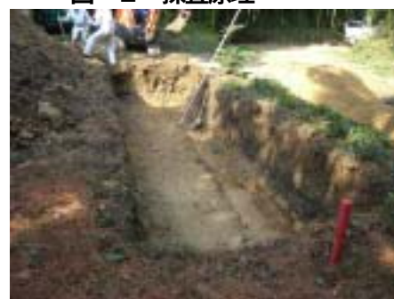
図-2 実験ヤード掘削状況
