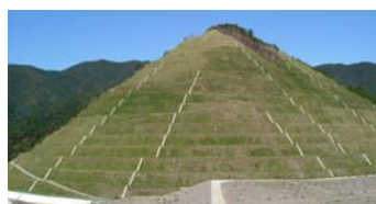
岩盤法面の全景（2004.12）
