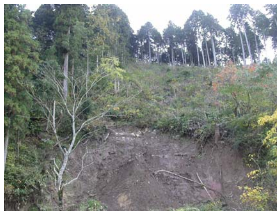
写真1 福井豪雨を誘因とした斜面崩壊
