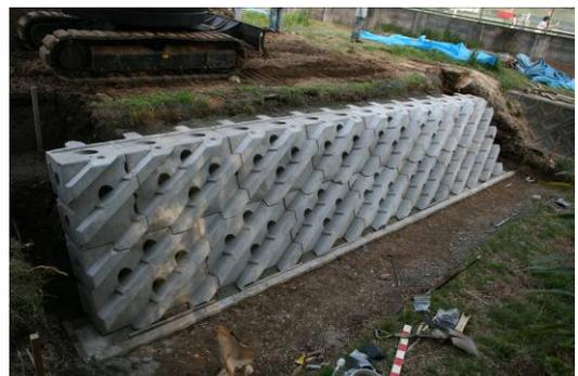
写真3 上段ブロック据付完了の外観
