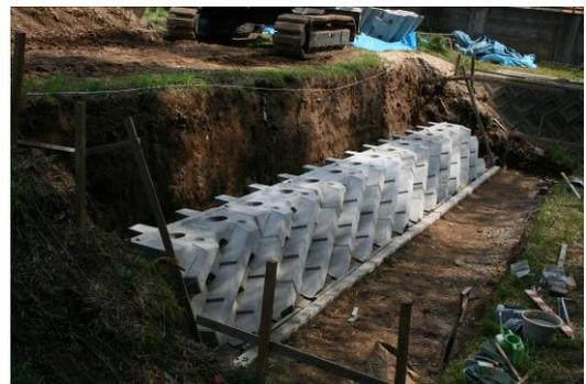
写真2 下段ブロック据付完了の外観
