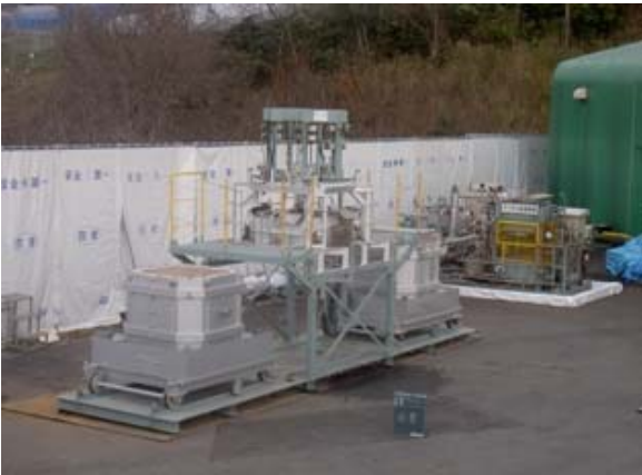
図-2 溶融設備の設置(防音パネル覆い前)
