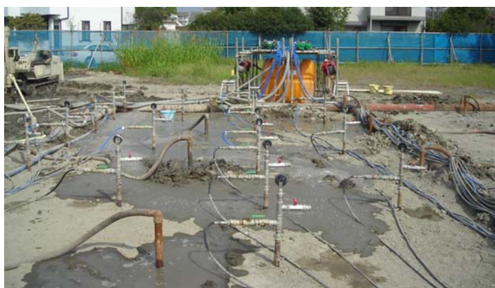
写真-1 多深度段階注入工法の状況
