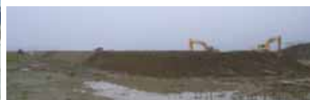
写真-3 パイル造成完了
