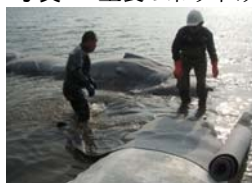
写真-7 透水シートの設置
