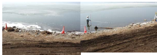
写真-2 施工前の状況(2008年3月12日)
