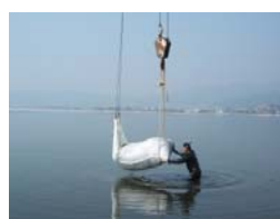
写真-4 土嚢の吊り下げ
