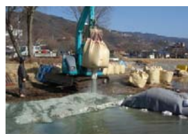
写真-9 湖岸へのゼオライトの敷設
