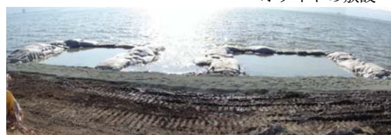
写真-10 施工完了後の全景（2008年3月15日）
