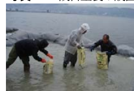
写真-8 圍繞堤内へのゼオライトの敷設
