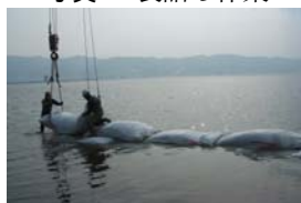
写真-6 2段目土嚢の設置
