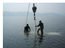
写真-5 1段目土嚢の設置
