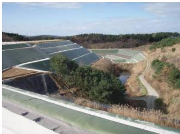
写真-1 雨水制御・遮水シートの状況
