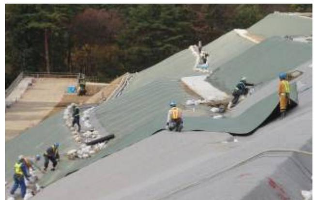
写真-4 遮水シートの施工状況
