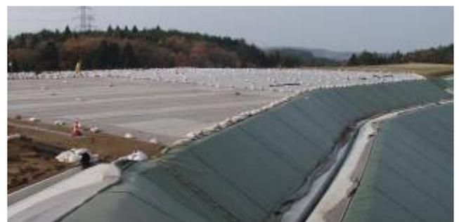
写真-3 雨水制御シートの施工状況
