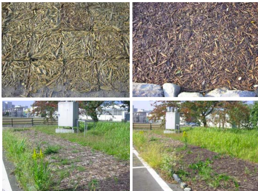
図4 施工後の状況
