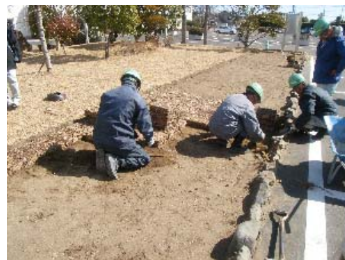
図2 試作した試験体の施工
