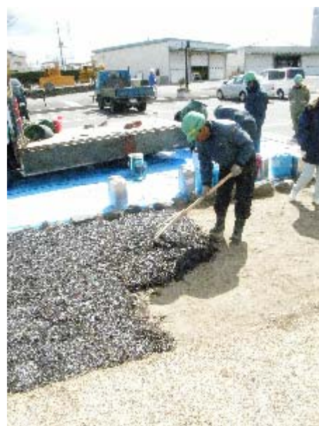
図3 現場施工の状況
