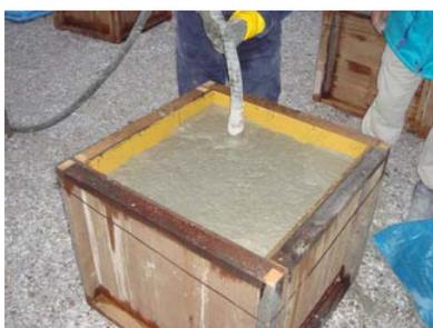
写真-8 締固め状況
