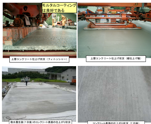
図-3 試験施工状況写真
