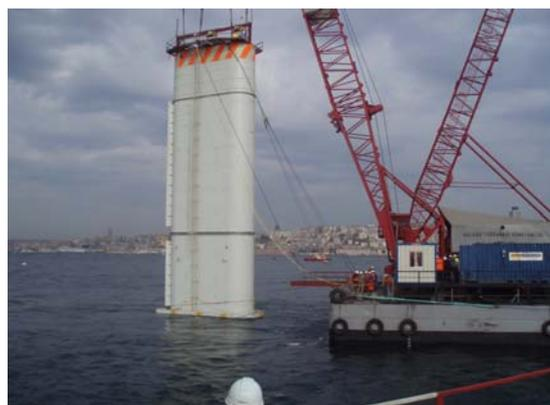
写真1 仮設立坑架設状況
