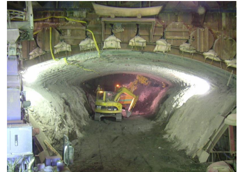
写真-1 上半中央上部掘削状況
