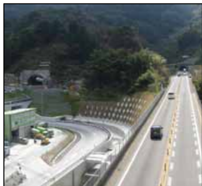
写真-1 北坑口(左側が 期線, 右側が 期線)
