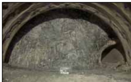
写真-3 避難坑すり付け区間
