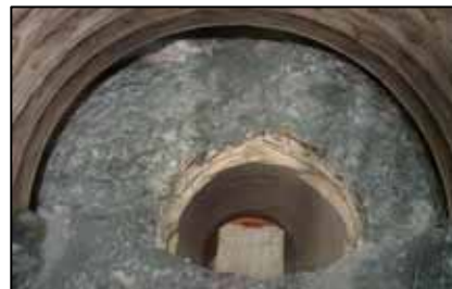
写真-4 避難坑拡幅区間
