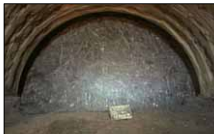
写真-2 避難坑近接区間(全断面掘削)
