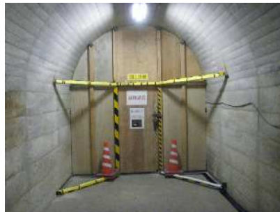
写真-3 避難連絡坑防爆扉(木製)
