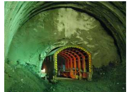
図-4 プロテクター設置状況図
